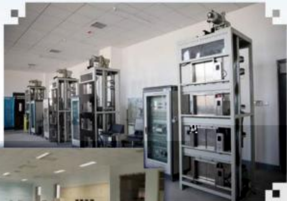
智能电梯安装调试维护训练场所
